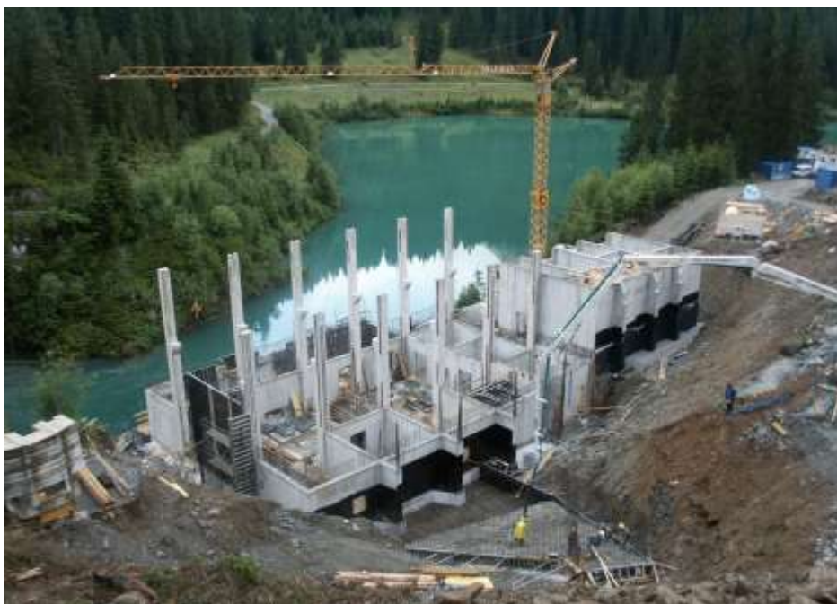
Электростанция (Св.Антон, Австрия, 2004), Система гидроизоляции: 111N и Dickbeschichtung 2K Standart
